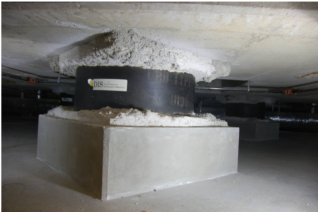
圖三、鹽湖城猶他州州政府大樓地下室的防震隔離樁
